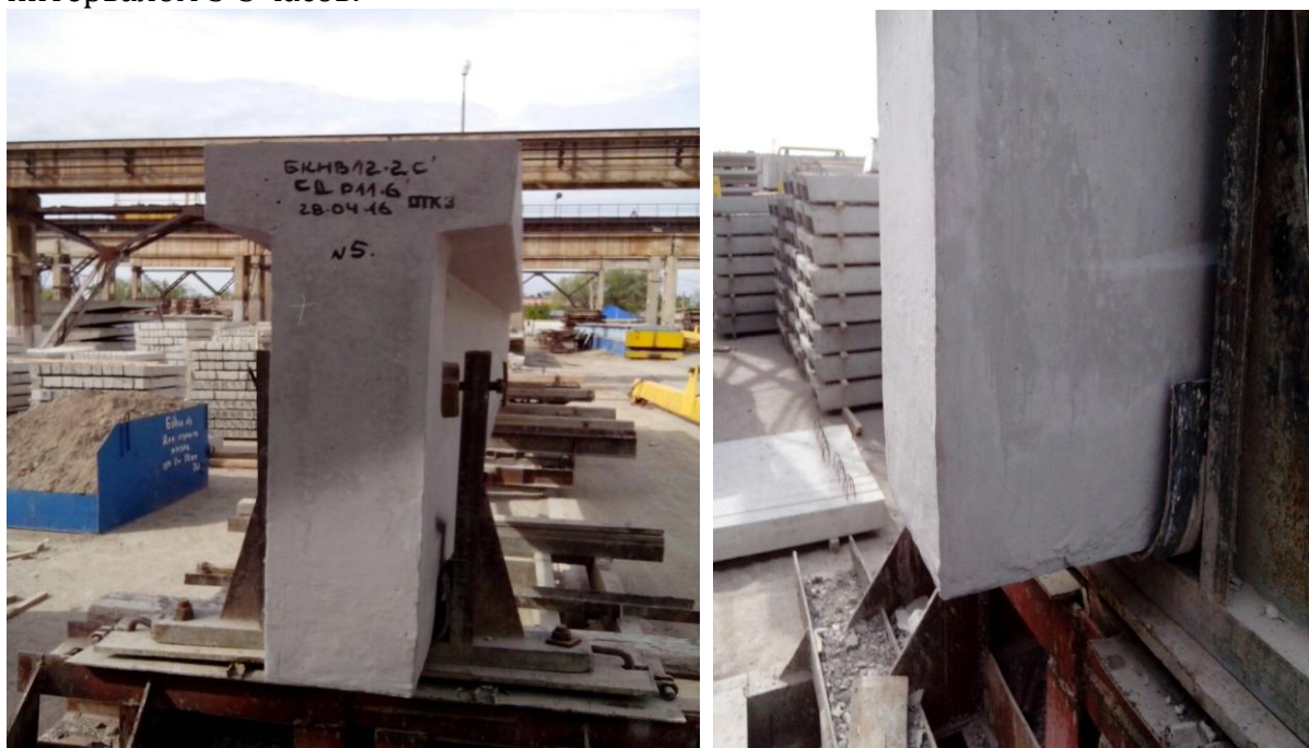
Фото 5. Железобетонные конструкции ТОО «Стройдеталь», проработанные ремонтным составом на основе наноцемента 75
